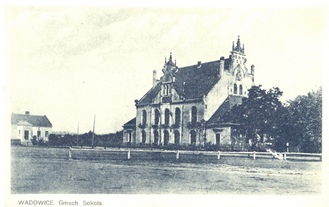
Budynek Towarzystwa Gimnastycznego „Sokół” w Wadowicach. Fot. archiwum
